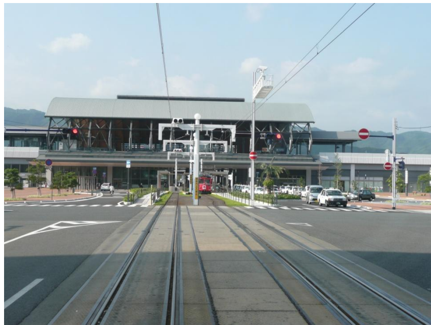
整備された軌道（JR高知駅前）
