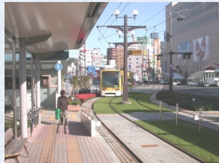
路面電車走行 空間改築事業
