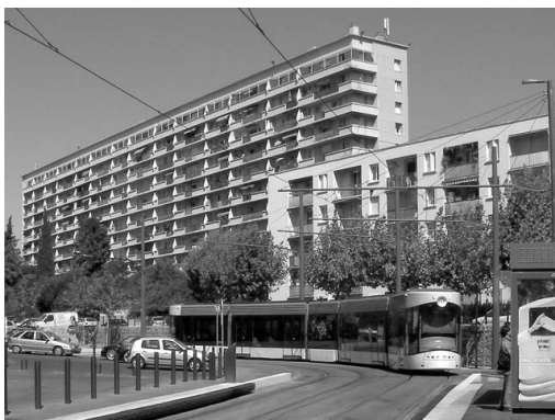
写真 1 マルセイユ T1 沿線の集合住宅
