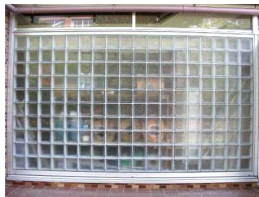
写真-5 デジタルカメラ画像のひずみの例
