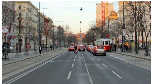
写真-3 歩道側に寄せられた軌道の例（ウィーン市内）
